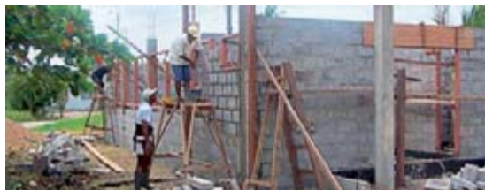
Kościół w trakcie budowy
